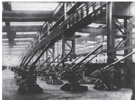
Fabrication de canons antiaériens dans le « bâtiment des machines » des Aciéries d'Allemagne centrale de Gröditz (Mitteldeutsche Stahlwerke Gröditz), non daté
