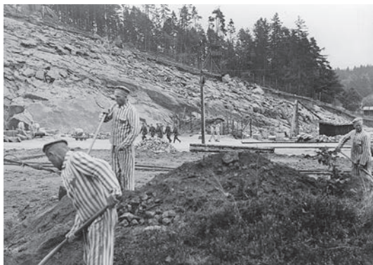
Prisonniers au cours de travaux de terrassement, à l'arrière-plan, un groupe de SS, photographie prise par la SS vers 1942
