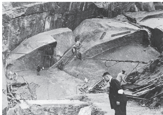
Employé de la DEST, prisonniers et kapos dans la carrière, photographie prise par la SS vers 1942
