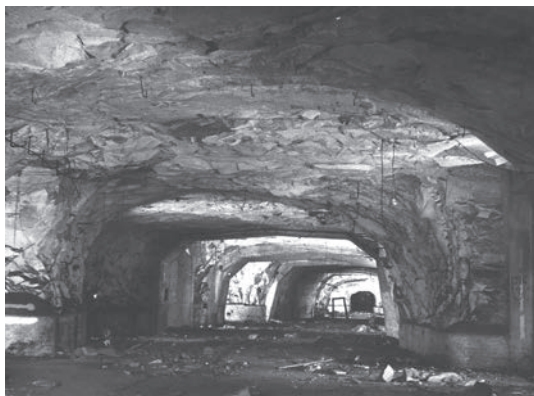
Pohled do štol v Litoměřicích/Leitmeritz, květen 1945
